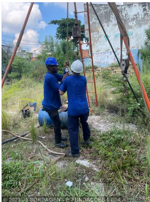
Foto 1 – Relatório Fotográfico das Atividades - Execução de Sondagem à Percussão
